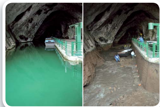
Fig. 2 L'atrio d'ingresso della cavità in una duplice veduta: a sinistra con le acque del torrente ipogeo trattenute da una diga artificiale; a destra con il bacino idrico di accumulo quasi completamente prosciugato in occasione di lavori di manutenzione.
