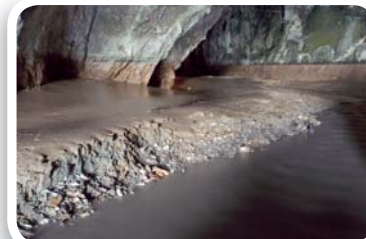
Fig. 9 L'alveo del torrente ipogeo in prossimità dell'edicola di San Michele, così come appare oggi allorché il livello delle acque viene artificialmente abbassato per lavori di manutenzione.
