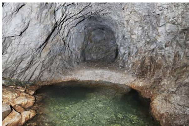
Fig. 4 - Veduta del sifone terminale come si presenta oggi: è evidente la natura artificiale dell'ambiente sopra la sorgente da cui scaturiscono le acque sotterranee (foto F. Larocca).
