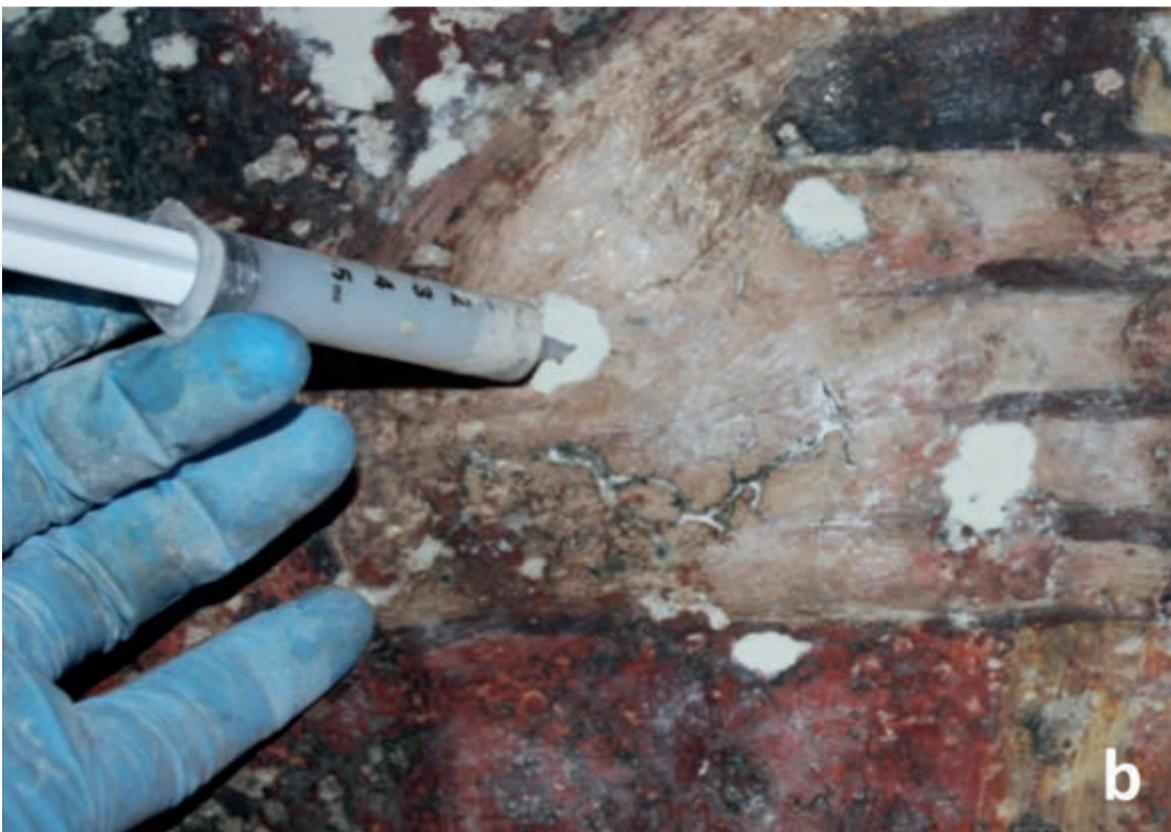
Fig. 8. Consolidamento degli strati preparatori: realizzazione dei fori (a) e iniezione della malta (b) (foto: A. Smeriglio).
